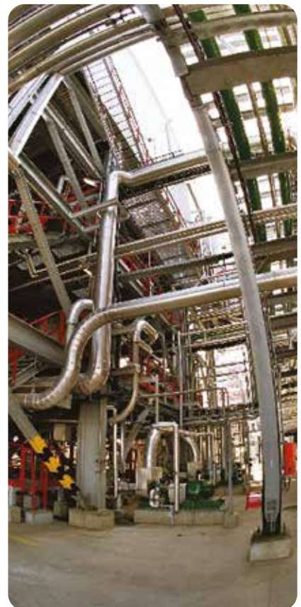
Revestimientos de estructura metálica
